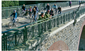
Bahntrasse mit Viadukt, Lindlar-Bruch
